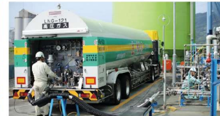
▲ ローリー車から天然ガス を受け入れる様子
