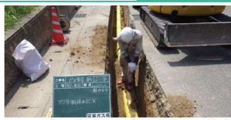
▲ ガス管を道路に設置する工事の様子
